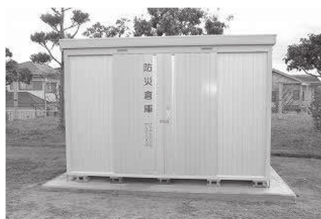
※けやき台自主防災会が設置した防災倉庫
