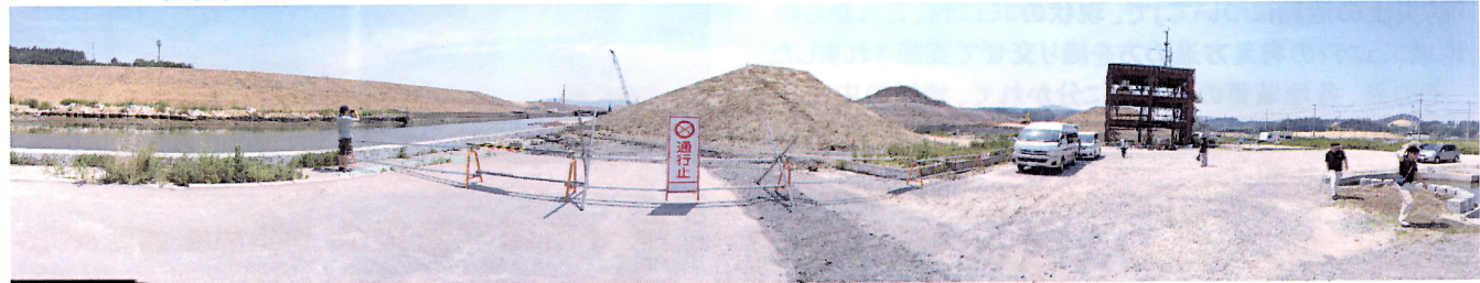
陸前高田市 南三陸町 防災対策庁舎
